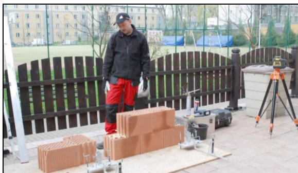
Pokaz murowania systemem Porotherm DRYFIX – Zakład Produkcyjny i Skład Firmowy Wienerberger Gnaszyn
