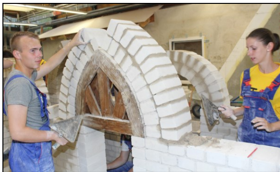
Uczniowie podczas murowania ścian i łuków
